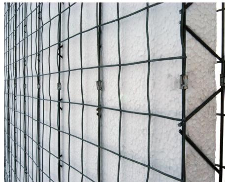
Alambre de acero de bajo carbón SAE 1008 calibre 12 con uniones electrosoldadas en forma de zig-zag, moduladas a cada 15cms.
